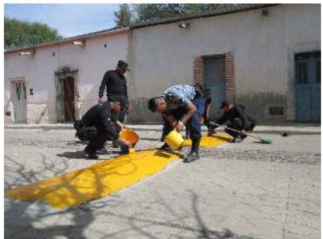
Pintando topes para mejorar las señales de tránsito.
